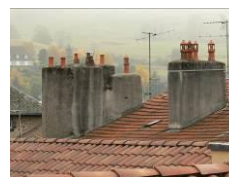
Souches maçonnées « épaisses » et poteries
