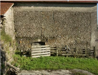
Architecture rurale à murs moellonnés
