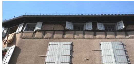
24, rue des Frères. Combles ouvert (15 e – 16 e siècle ?). De grandes ouvertures avec aisseliers ouvraient largement le comble. Les baies ont été partiellement murées lors de l'installation de jours plus étroits.
