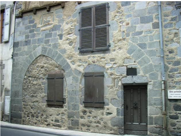
Façade « archéologique » : la présence de moellons laisse la pierre de taille exprimer la composition architecturale
