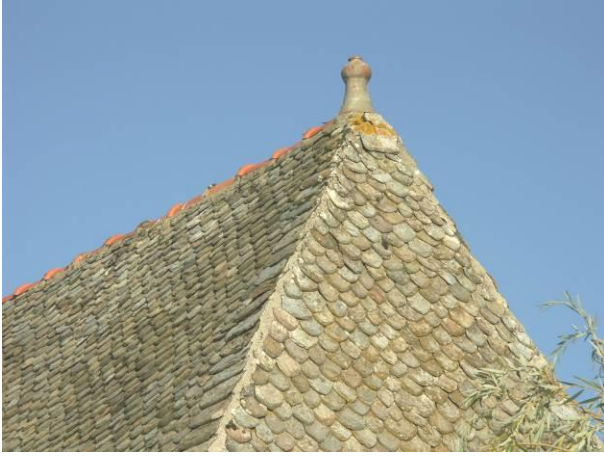
Couvertures en lauzes de schiste épaisses : essentiellement l'architecture rurale et nombre de maisons anciennes
