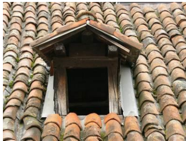
Petite lucarne de ventilation de toiture
