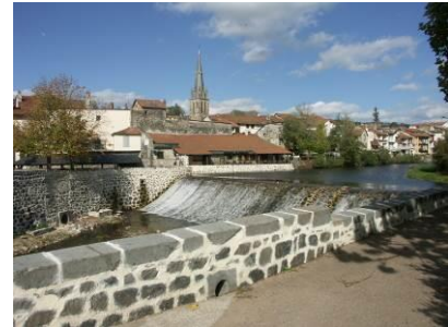
Il faut veiller à éviter de traiter le joint en maçonnerie blanc pur, car cela fait ressortir le moellon en « pointillisme » !
