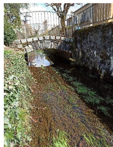
Canal en eau
