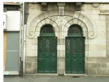
Encadrement de baies
