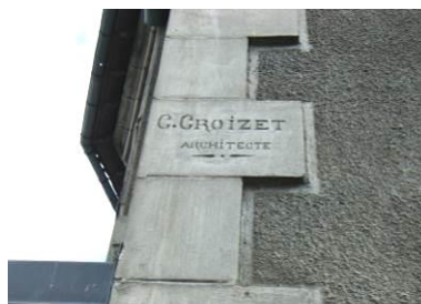
Chainage d'angle en pierres de taille et remplissage enduit. (architecture « moderne », avec pierres de taille en saillie)
