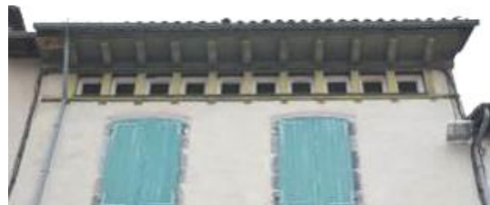
2, rue Marchande, 18 e siècle. Les métopes ont été ouvertes et vitrées pour éclairer le comble.
