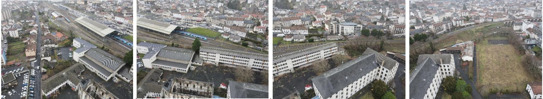
Le site a été doté de nouveaux bâtiments scolaires au nord, dont un gymnase à gauche ; un terrain de sport occupe l'extrémité est
