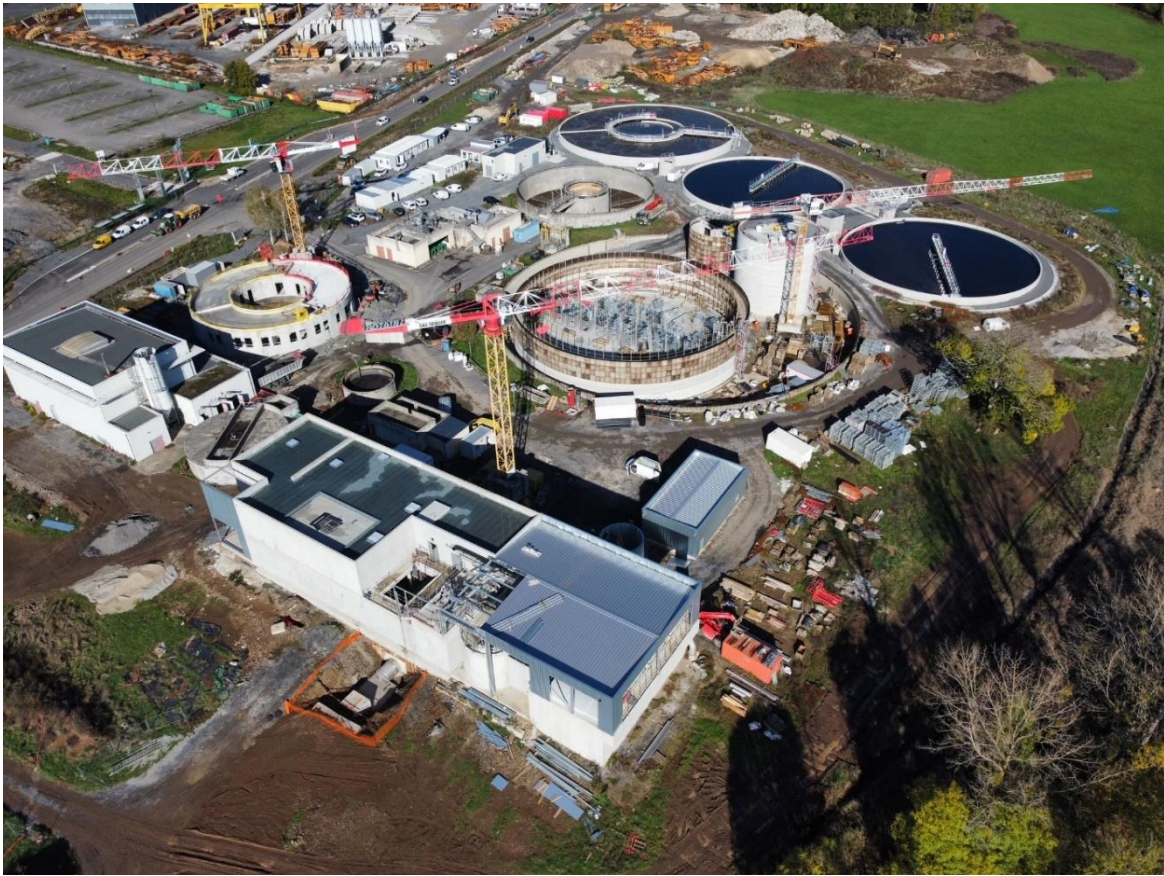
Photographie du chantier en novembre 2022
