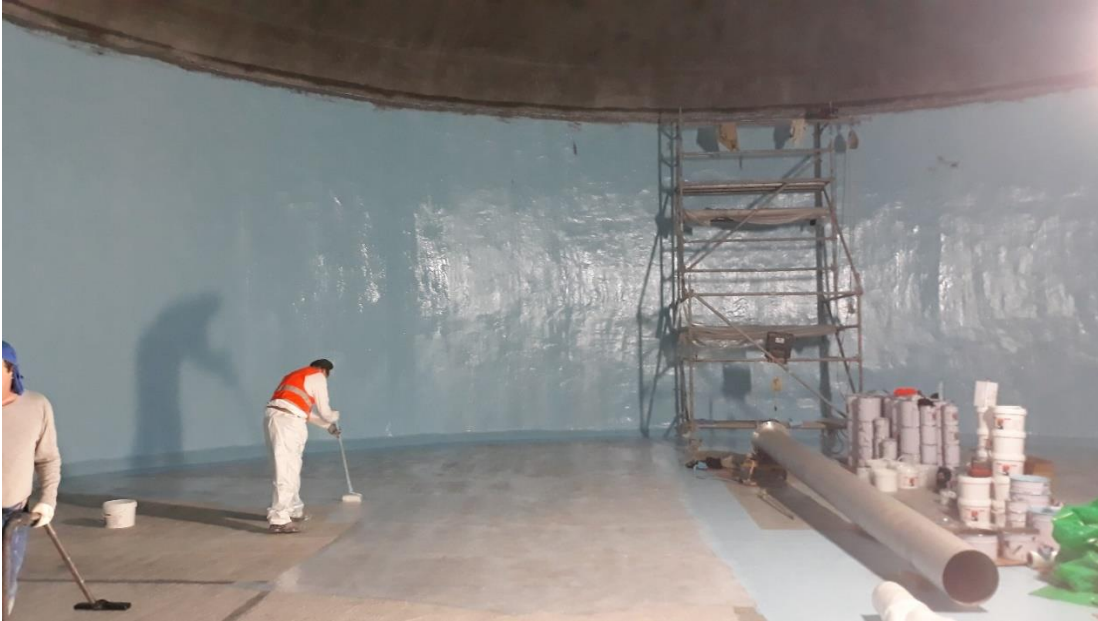
Travaux de résine Coissy 1
