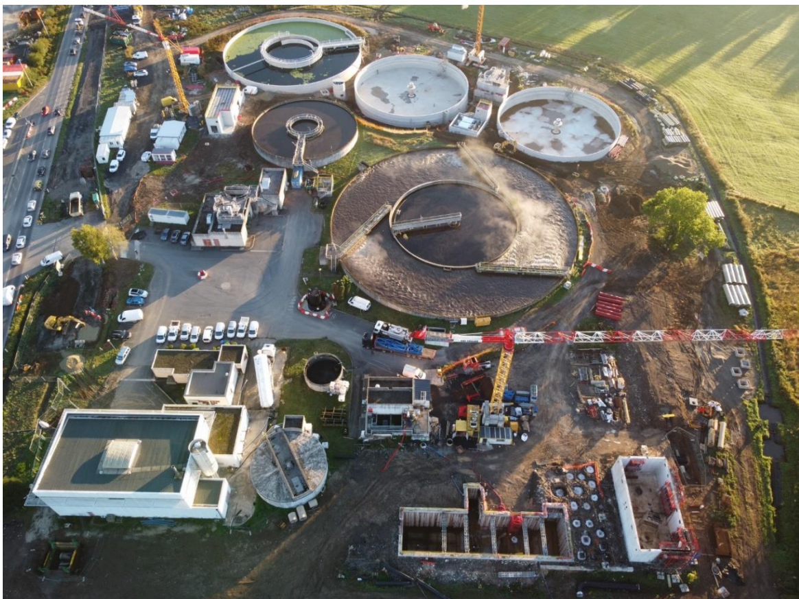
Photographie du chantier en septembre 2021
