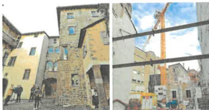
Réhabilitation - restructuration d'îlot
