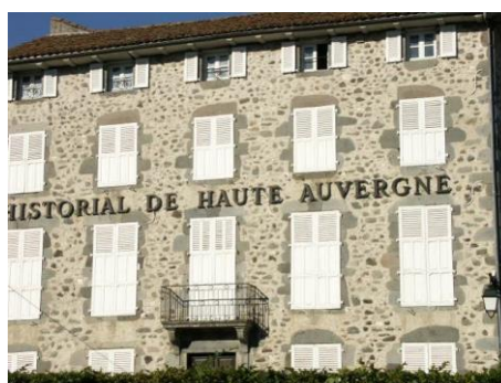
Lorsque la façade est ordonnancée, comme ci-dessus, les volets doivent tous se présenter suivant le même modèle, pour l'ensemble de la façade.
