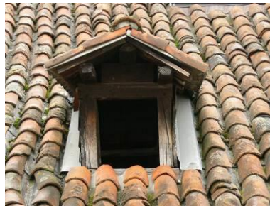
Petite lucarne de ventilation de toiture
