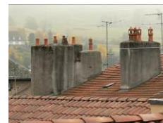
Souches maçonnées « épaisses » et poteries
