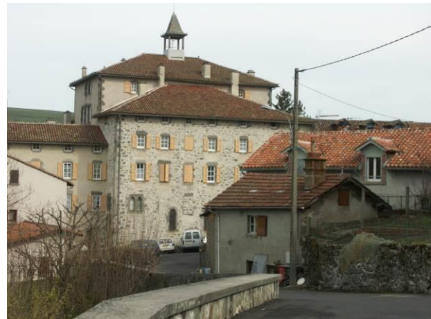
Façades moellonnées enduites « à fleur de moellons »
