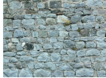
Murs à moellons posés par assises irrégulières
