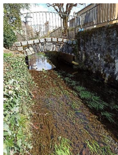
Canal en eau
