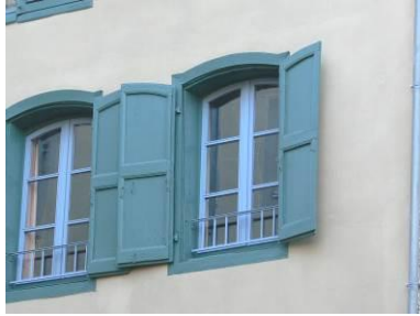
Menuiseries classiques à 2 vantaux de 3 carreaux
