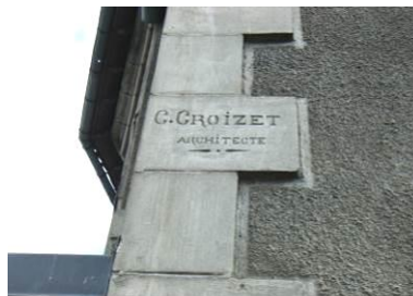
Chainage d'angle en pierres de taille et remplissage enduit. (architecture « moderne », avec pierres de taille en saillie)
