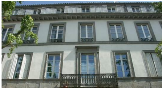
L'ordonnement des baies suppose un modèle de menuiseries identique sur toutes les fenêtres
