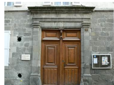
Mur entièrement en pierre assisée et porte en pierre de taille
