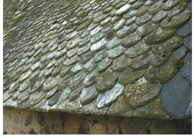
Couvertures en lauzes de schiste épaisses : essentiellement l'architecture rurale et nombre de maisons anciennes
