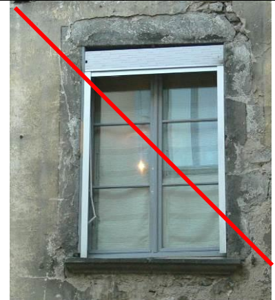
Ci-dessus : les baies traditionnelles ne sont pas conçues pour recevoir des volets roulants extérieurs
