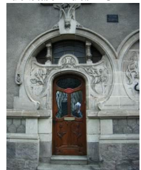
Porte décorative Art Nouveau, en harmonie avec l'architecture de la façade, au début du XX ème siècle. Au milieu du XIX ème et au début du XX ème s, les vantaux de porte sont vitrés ; le vitrage est doublé de grilles décoratives en fonte ou en fer forgé.
