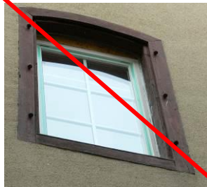
Le partage du vitrage par bois intérieurs se voit et se présente comme « un faux ».
