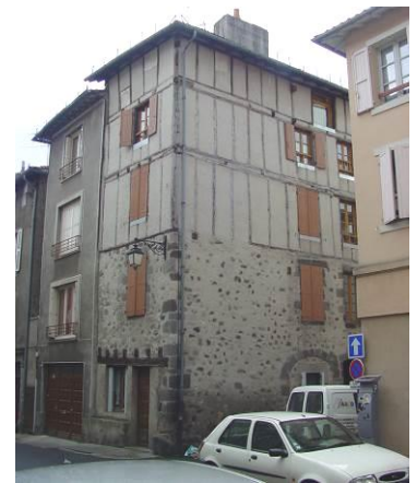
Pan de bois en grille : structure de poteaux.
