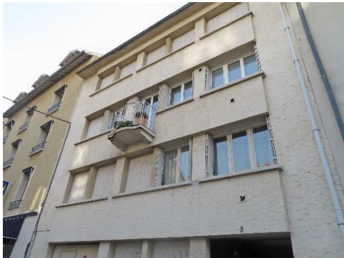
Exemple d'immeuble qui peut être l'objet d'adaptations architecturale pour une isolation thermique par l'extérieur.
