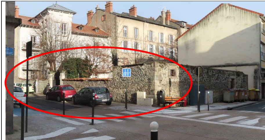
Vue depuis carrefour rue Guy de Veyre et rue du 14 Juillet : mur et piliers
