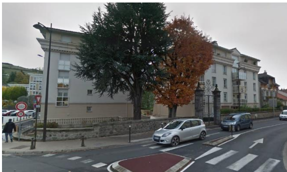
41 avenue Paul Doumer : les 2 arbres et le portail
