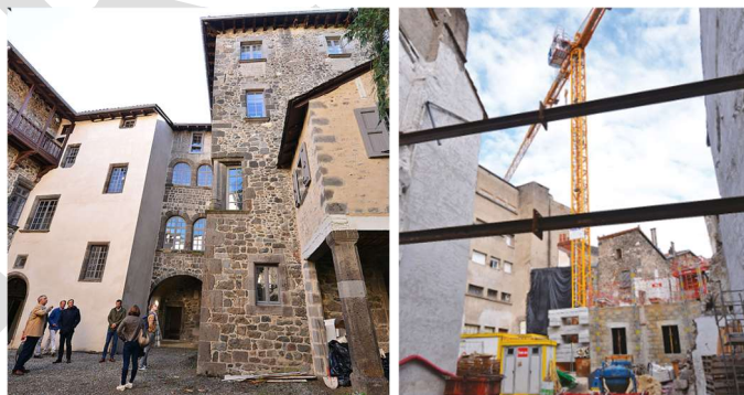
Réhabilitation - restructuration d'îlot
