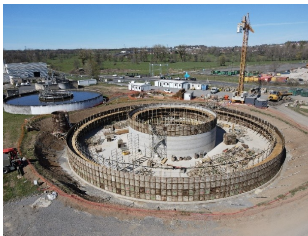
Bassin d'aération en construction
