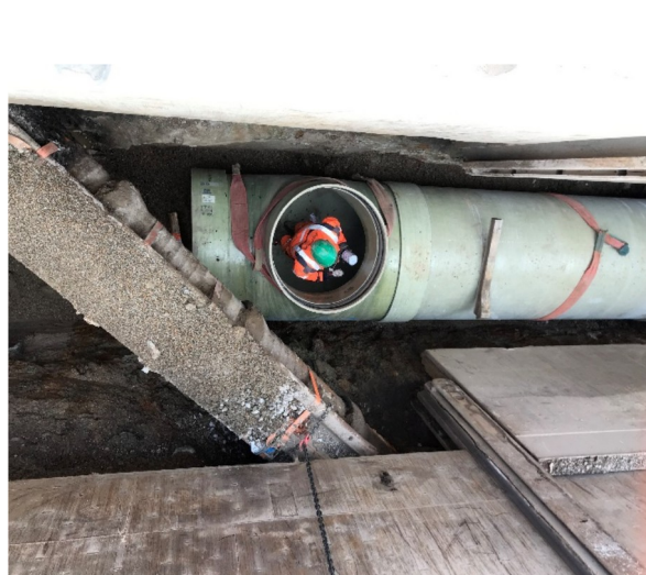
Réseau en cours de pose à 5 m de profondeur
