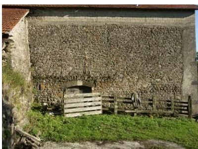
Architecture rurale à murs moellonnés
