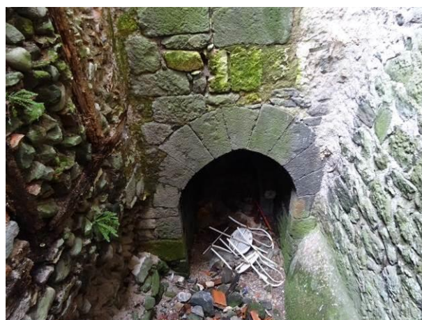
Arcade : entrée d'une maison romane
