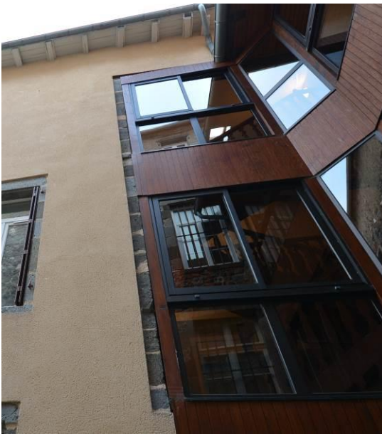
Des rapports de textures et matériaux entre eux
