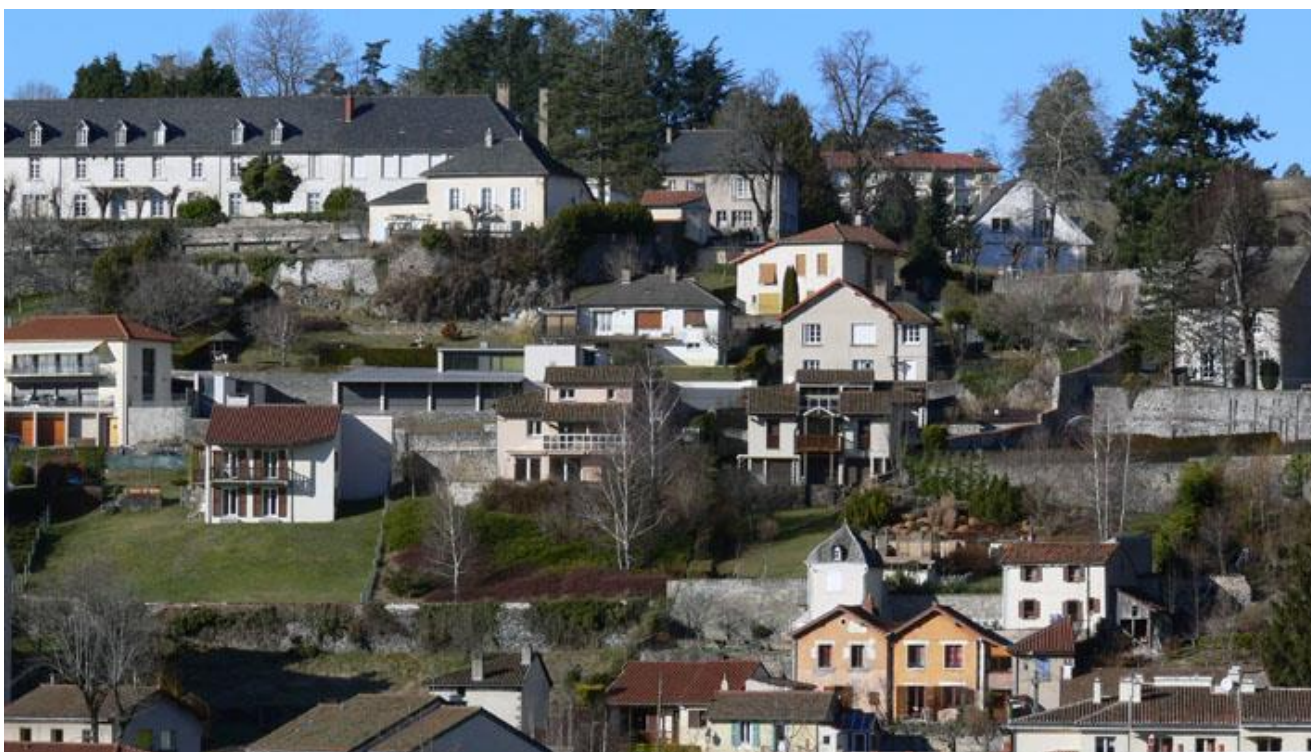
Abords du château : l'insertion de l'architecture contemporaine est possible, lorsque la coloration générale des lieux et le jeu des formes horizontales intercalées entre les volumes s'inscrivent dans les dispositions dominantes du site.
