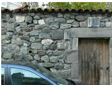
Mur à gros moellons
