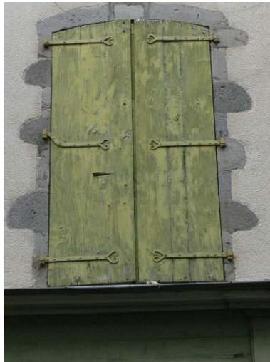
Volet à larges planches pleines
