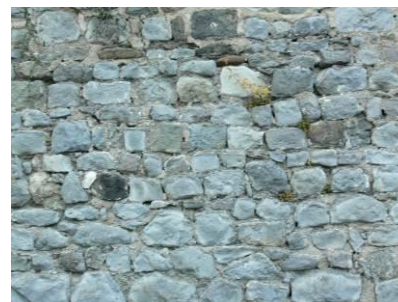
Murs à moellons posés par assises irrégulières
