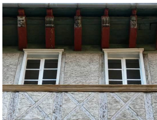
Le cordon d'appui horizontal et l'encadrement en bois des fenêtres étaient les seuls à apparaître du nu du mur enduit.
