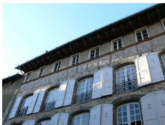
Dernier étage, en surcroît à pan de bois, d'une façade maçonnée.
