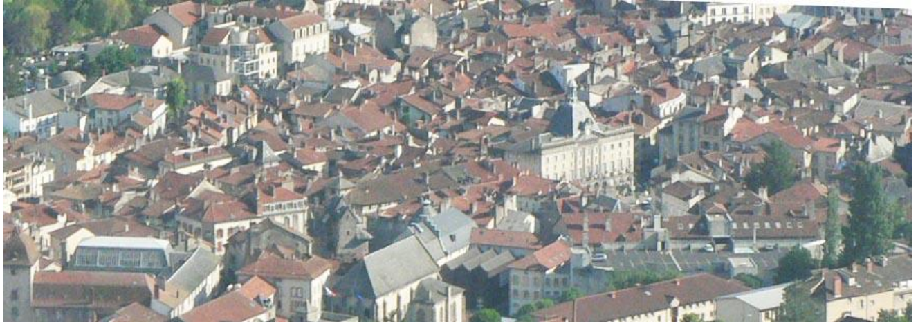
Dominante de toitures couvertes de tuiles dans l'intra-muros
