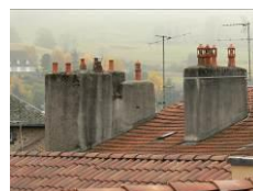
Souches maçonnées « épaisses » et poteries
