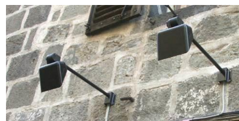
L'installation de l'éclairage doit être aussi discrète ou simple que possible et l'intensité adaptée au lieu.
