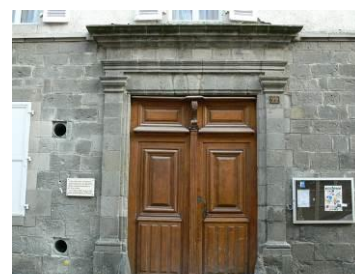
Mur entièrement en pierre assisée et porte en pierre de taille
