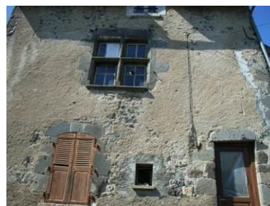
Fenêtre à meneau en pierre
