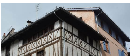
24, rue Victor Hugo. 18 e siècle. Comble ouvert à structure de petites croix de Saint-André en allège et poteaux. Un cordon mouluré en bois souligne l'appui des ouvertures.
