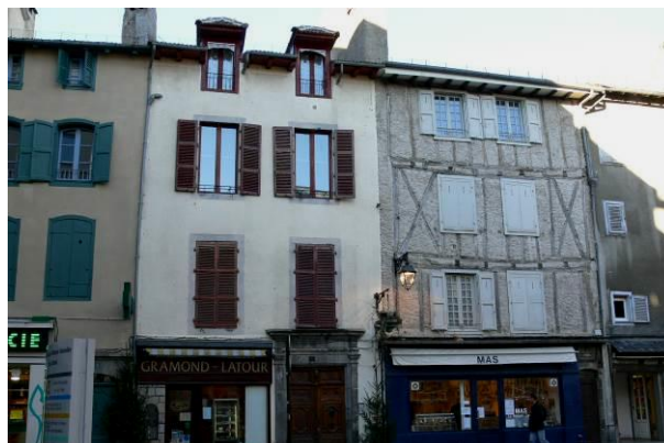
Inscrit dans un front bâti constitué de façades enduites, le pan de bois mis à nu, alors qu'il n'est pas composé pour être vu, apparaît un peu incongru et perturbe l'unité architecturale et urbaine.
