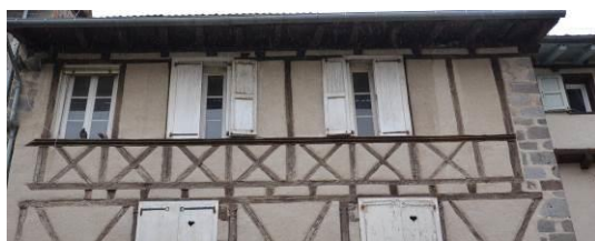
3, rue du Collège. 16 e siècle. Le comble, initialement ouvert, est constitué d'un niveau d'allège en petites croix de Saint-André et d'un cordon d'appui en bois mouluré.
