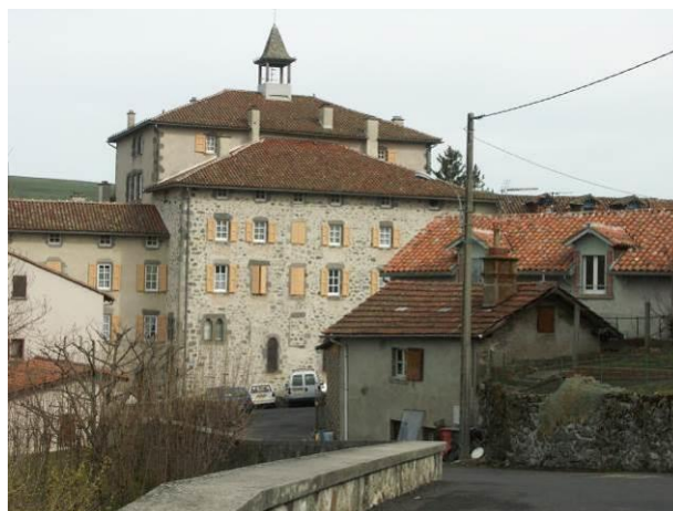
Façades moellonnées enduites « à fleur de moellons »
