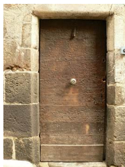
Porte à planches croisées verticales sur la face intérieure, horizontales sur la face externe. C'est la porte type des menuiseries courantes de l'architecture médiévale.
