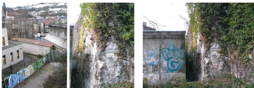
Témoignage de la présence d'un mur de rempart (photos UDAP du Cantal)
